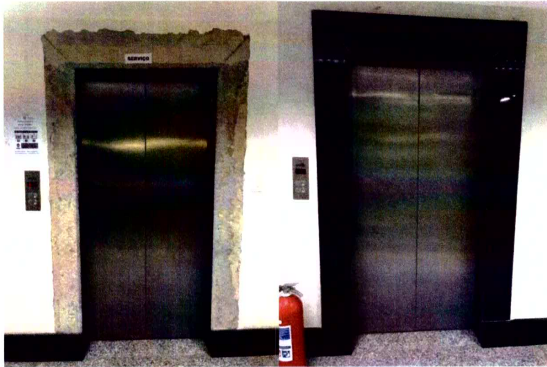
Foto 1: Antes e depois- fachada elevador G1.
